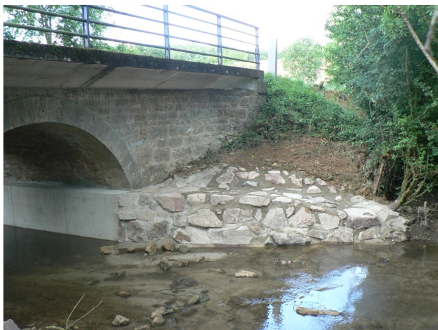
Travaux d'aménagement réalisés sur l'année 2023 en faveur de la loutre (banquettes et passerelles à Metz-le-Comte)
