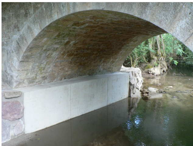
Travaux d'aménagement réalisés sur l'année 2023 en faveur de la loutre (banquettes et passerelles à Metz-le-Comte)
